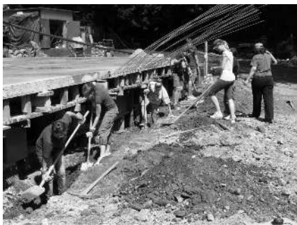
06 výkop pre odvodňujúce potrubie
